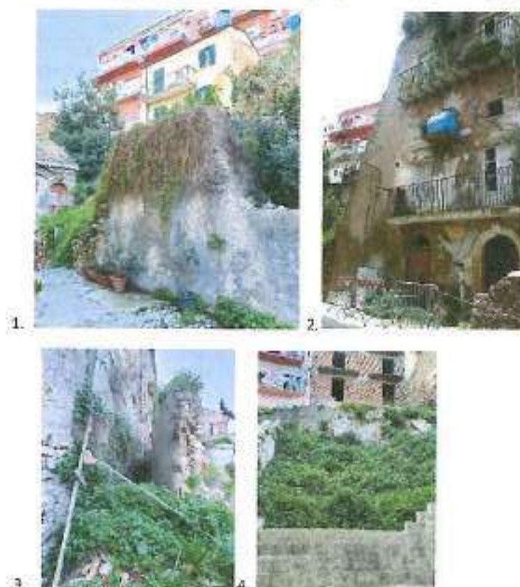
1) VISTA DEL MURO DI CONTENIMENTO INN CLS DA VIA R. PILO. 2) VISTA DELL'EDIFICIO ANTE DEMOLIZIONE. 3) VISTA DEI RESTI DEL MURO PERIMETRALE SU VICOLO MONZA. 4) VISTA DELL'AREA INCOLTA ALL'INTERNO
