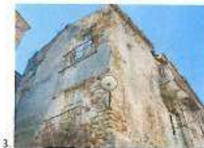
1) VISTA DA VIA R. PILO. 2) VISTA DA VIA VESCOVO NATOLI. 3) VISTA D'ANGOLO, CON IN EVIDENZA IL CROLLO DEL TETTO E DELL'ARCHITRAVE IN CORRISPONDENZA DELLA FINESTRA. 4) VISTA DEL TETTO CROLLATO DA PIAZZA SCAFFIDI
