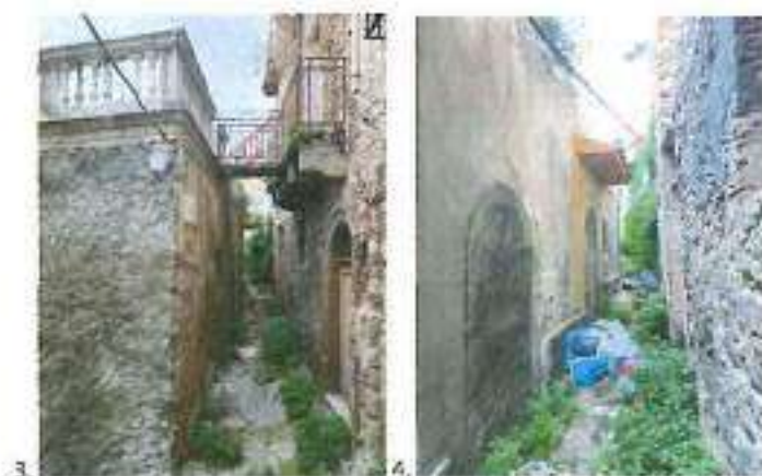
1,2) VISTE DELL'ANGOLO SU VIA ROSOLINO PILO. 3,4) VISTE DELL'ANGOLO TRA VIA R. PILO E VICOLO MONZA. SI NOTA LA PASSERELLA DI COLLEGAMENTO TRA L'UNITA' 384 E 372
