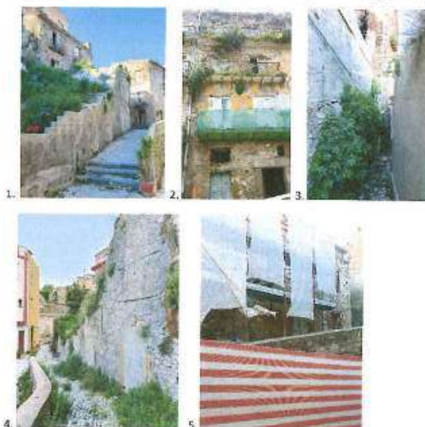
1) VISTA DEL MURO PERIMETRALE DI CONTENIMENTO DA VIA ROSOLINO PILO. 2) VISTA DELLA FACCIATA ANTE DEMOLIZIONE. 3) VISTA DEL MURO LUNGO RESIDUALE LUNGO VICOLO MONZA. 4, 5) VISTA DA VIA R. PILO DOPO E DURANTE LA DEMOLIZIONE
